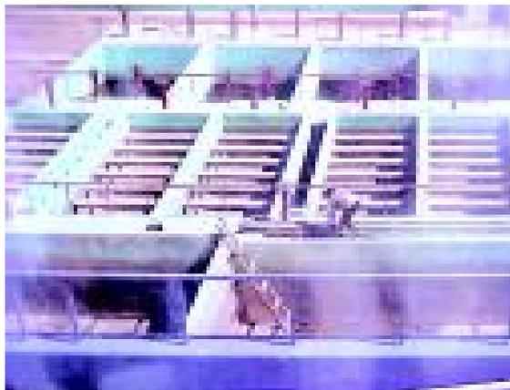
**Figura 4-2.** Rotura de placas de sedimentadores de la planta de tratamiento de Moquegua, Perú, debido a un sismo de mediana intensidad ocurrido en el año 2001
