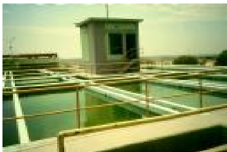
Figura 3-8. Decantador pulsante de sección rectangular (5)
