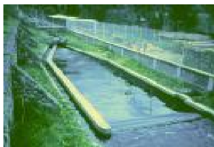
Figura 2-1. Desarenador con canal de desviación (1)
