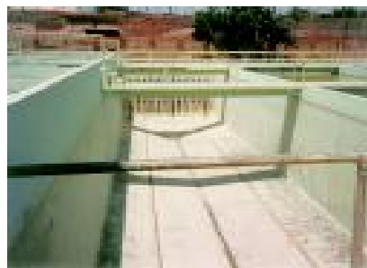
Figura 2-48. Decantador estático de flujo horizontal (1)
