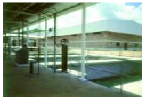
Figura 2-84. Batería de filtros de tasa declinante y lavado mutuo de gran capacidad (1)
