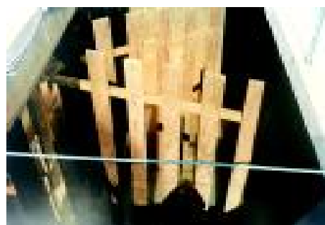
Figura 2-46. Floculador de paletas de eje vertical (1)
