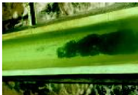
Figura 2-75. Pérdida de arena por exagerada expansión (1)
