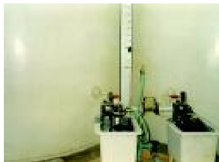
Figura 2-26. Dosificadores en solución del tipo de orificio (1)
