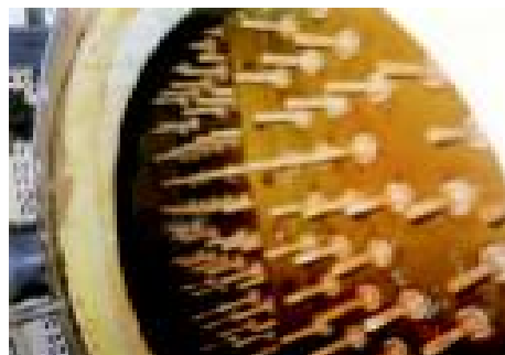
Figura 2-91. Drenaje de boquillas del filtro a presión (1)
