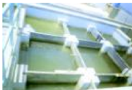
Figura 2-40. Floculador de flujo helicoidal (1)
