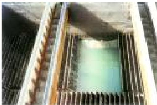
**Figura 1-3.** Las placas rotas deben reemplazarse de inmediato
