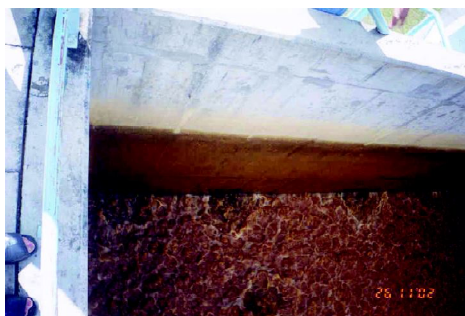
Figura 4-14. Lavado con aire y agua (2)
