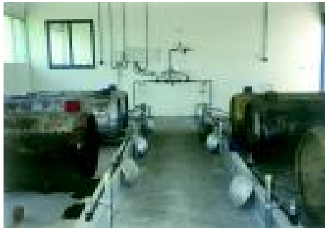
Figura 3-113. Almacén con ventilación forzada (1)
