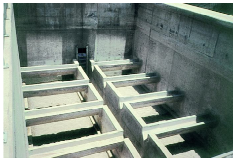
Figura 3-81. Canaletas de lavado en filtros grandes (1)
