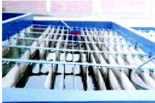
Figura 3-34. Segundo tramo del floculador evaluado (1)
