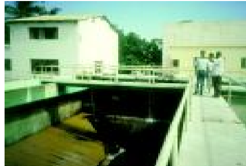
Figura 3-44. Decantador rectangular de flujo horizontal (2)
