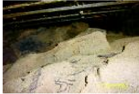
Figura A-25. La arena está en el falso fondo del filtro
