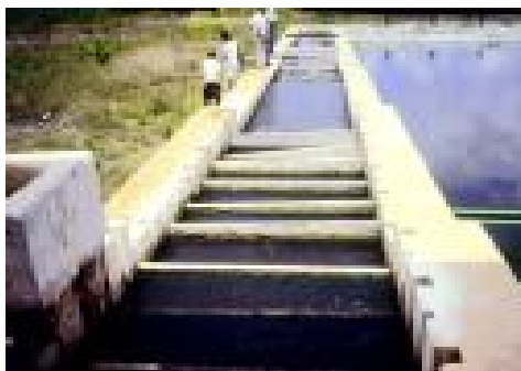
Figura 3-25. Floculador de pantallas de flujo vertical (1)
