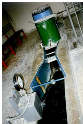
Figura 3-6. Sistema de dosificación en paralelo (1)
