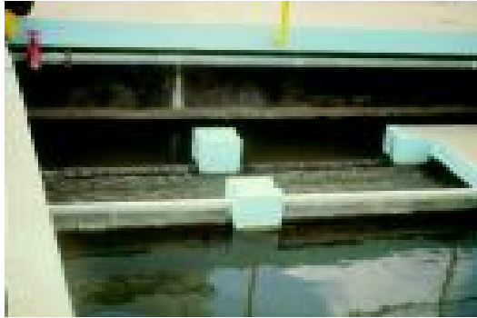
Figura 3-49. Entrada del decantador de vuelta en U (2)
