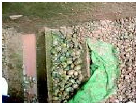
Figura 3-85. Se perdió la arena por falta de capa soporte (1)
