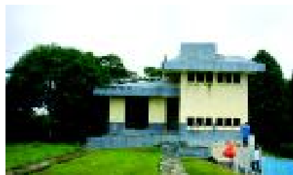
Figura A-1. Casa de química de la planta
