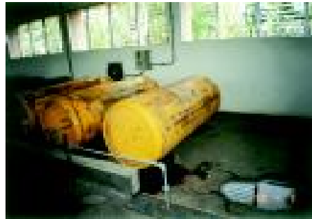
Figura 3-114. Almacén con muy poca ventilación (1)
