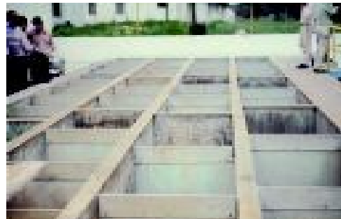
Figura 3-19. Floculador de pantallas de flujo vertical (1)
