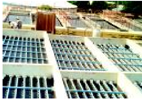
Figura 3-18. Unidad de pantallas de flujo horizontal (1)
