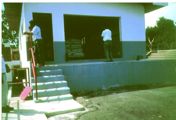
Figura 3-1. Características correctas del ingreso al almacén (1)
