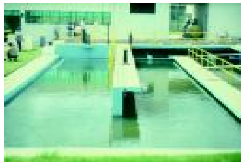
Figura 3-48. Decantador de vuelta en U (2)
