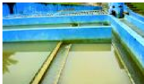
Figura A-22. Estructura de salida de decantadores
