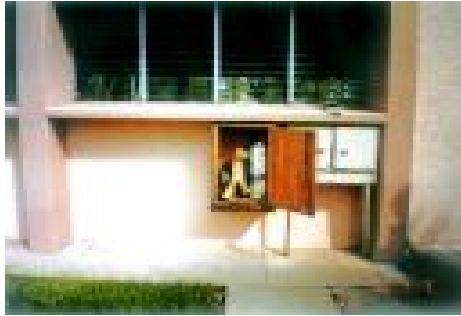
Figura 3-122. Sistema de protección ubicado en la puerta de la sala
