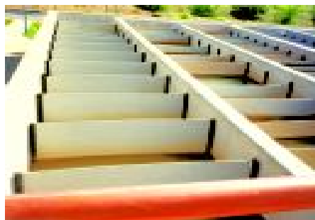
Figura 3-26. Floculador de pantallas (1)
