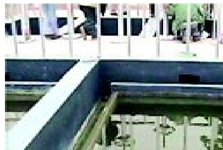
Figura 3-73. Vista de uno de los decantadores evaluados (2)
