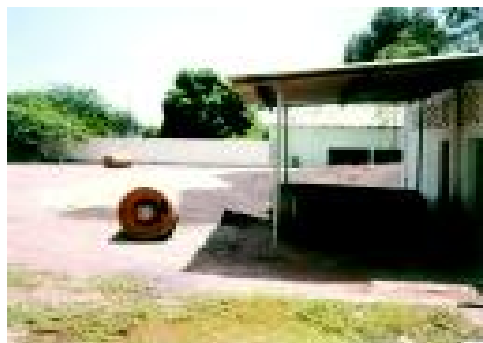
Figura 3-139. Caseta de poscloración improvisada (1)
