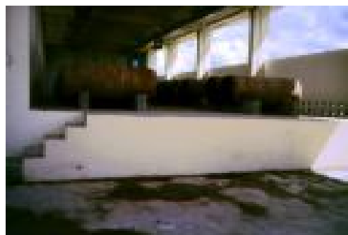
Figura 3-120. Almacén abierto con ventilación natural (1)
