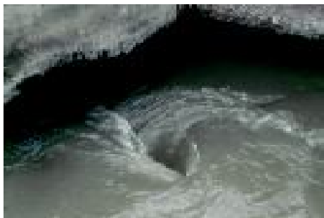
Figura 3-45. Una sola compuerta de ingreso (2)
