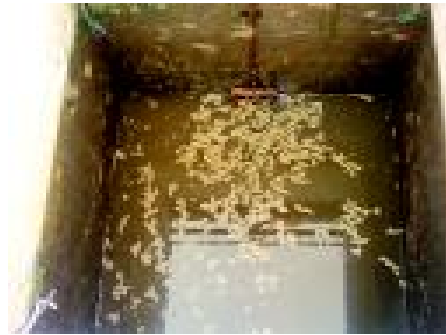
Figura A-23. El agua se represa durante el lavado
