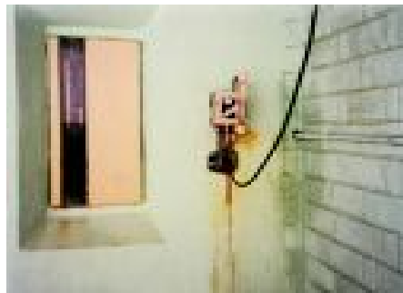
Figura 3-138. Dosificadores malogrados (1)
