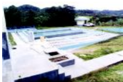
Figura A-2. Vista panorámica de la planta de agua
