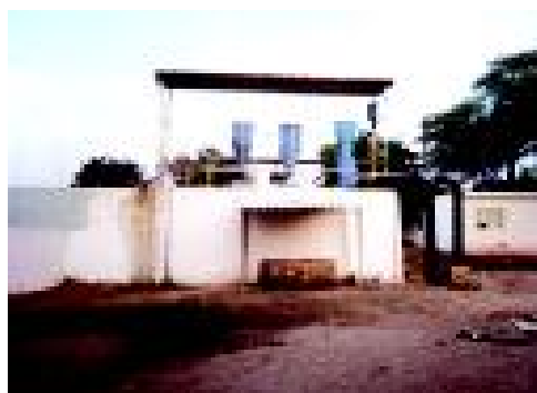
Figura 3-137. Caseta de precloración improvisada (1)
