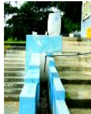
Figura A-7. Unidad de mezcla rápida
