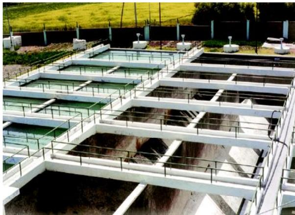
**Figura 2-24.** Vista del decantador de flujo horizontal (2)
