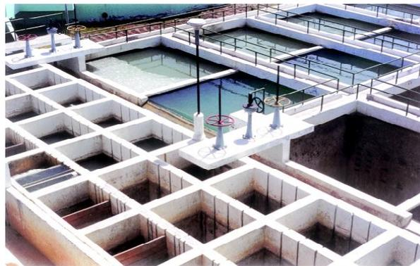
Figura 2-20. Vista del floculador hidráulico de la figura 2-19 (2)
