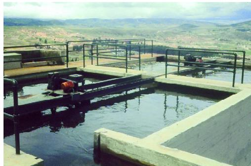
**Figura 2-14.** Floculador mecánico de una sola cámara (2)
