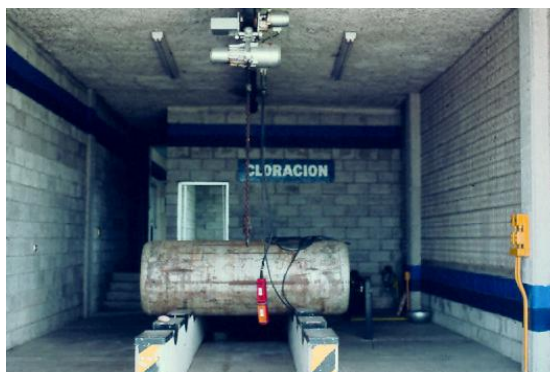
Figura 6-4. Forma de almacenar cilindros de una tonelada (2)
