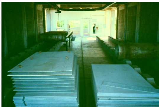
Figura 6-7. El almacén de cloro utilizado como depósito (2)
