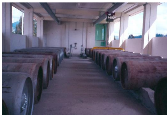
Figura 6-2. Almacén de cloro abierto para cilindros de una tonelada (2)
