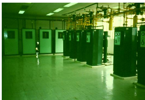
Figura 6-28. Evaporadores para operar con cloro líquido (2)
