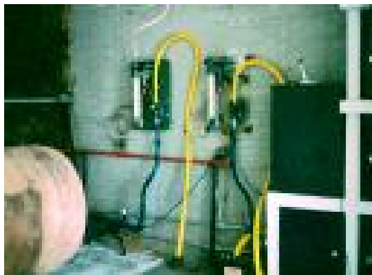
Figura 6-22. Cloración al vacío, equipos de pared (2)
