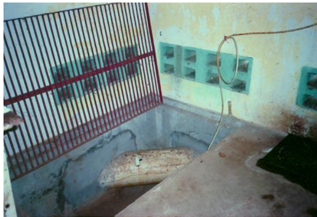
Figura 6-18. Punto de aplicación en la tubería (2)
