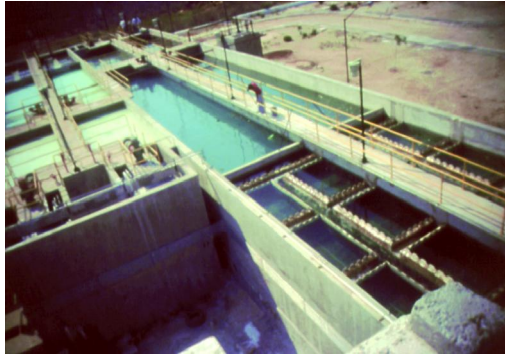
Figura 4-39. Decantadores convencional y laminar en serie (4)
