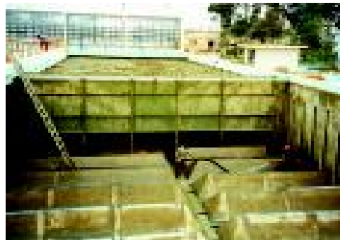
Figura 4-38. Decantadores convencional y laminar en serie (4)
