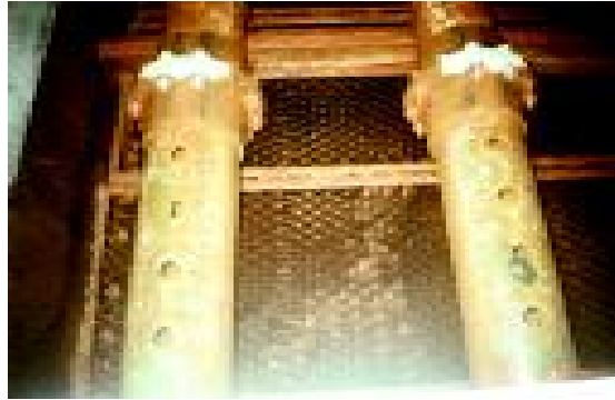
Figura 4-36. Sistema de recolección sobre los módulos de decantación (4)
