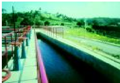
Figura 4-5. Canal de distribución a varios decantadores (4)
