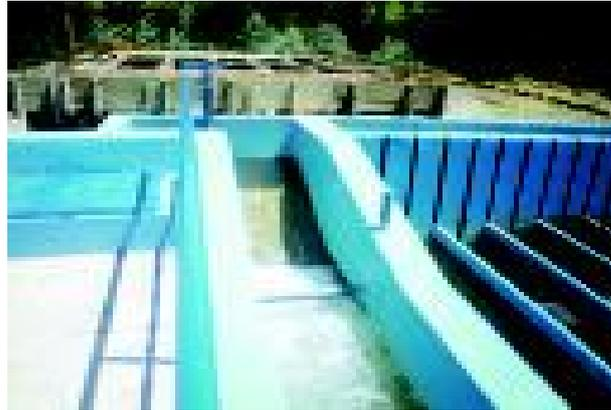
**Figura 2-4.** Mezclador del tipo rampa en una planta mediana (4)
