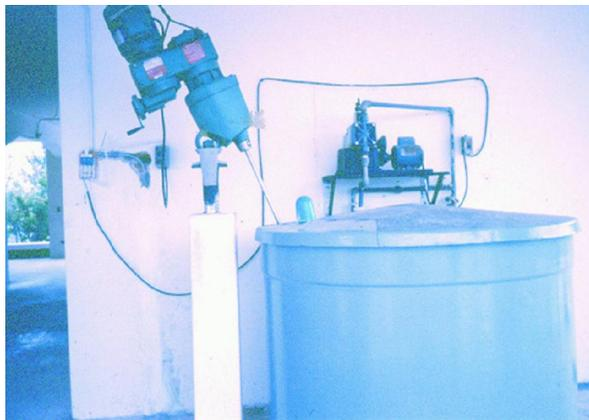
**Figura 1-16.** Sistema de dosificación por bombeo (1)
