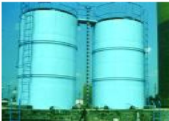
**Figura 1-8.** Tanque de almacenamiento de sulfato de aluminio líquido (1)
