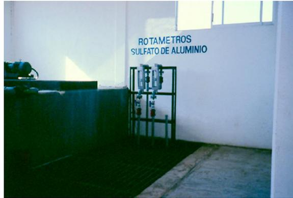
**Figura 1-17.** Sistema de dosificación por bombeo (1)
