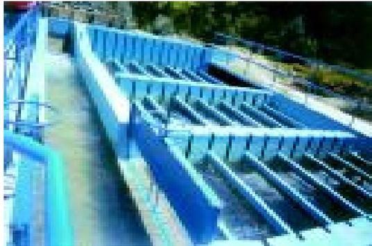
**Figura 3-6.** Floculadores hidráulicos de flujo vertical (3)
