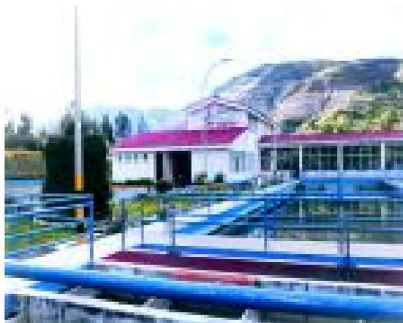
**Figura 3-1.** Decantador rectangular de flujo horizontal (3)
