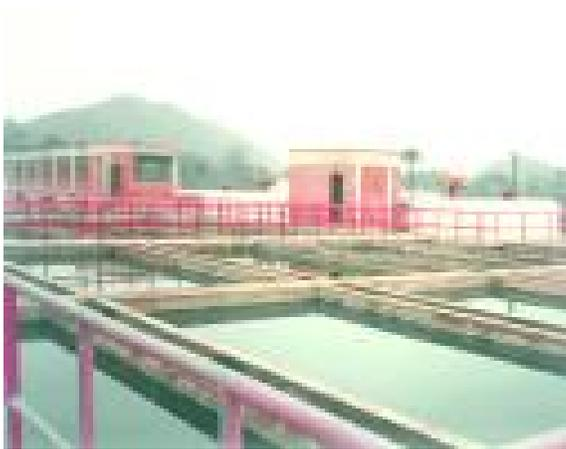
**Figura 3-8.** Decantador de manto de lodos (3)
