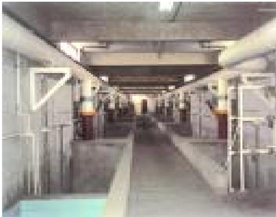
**Figura 3-9.** Galería de tubos de filtros de patente (3)
