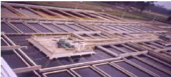
Decantador dinámico de suspensión mecánica
