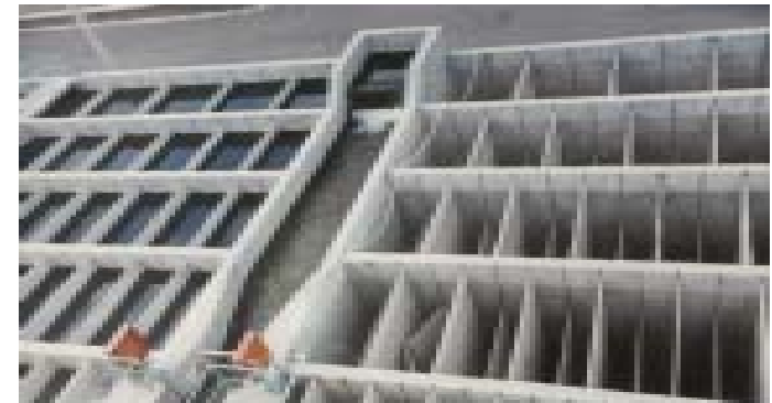
Floculador de pantallas de tipo vertical
