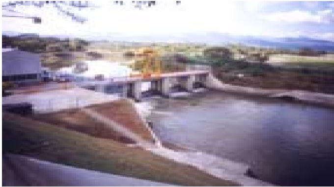
Captación de río
