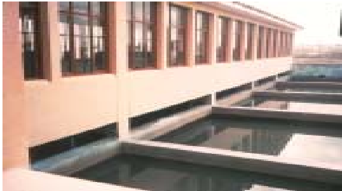
Filtros rápidos por gravedad operados a distancia mediante consolas o pupitres
