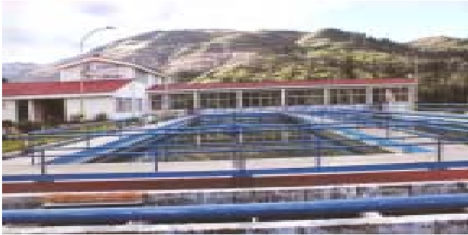
Decantador estático de flujo horizontal
