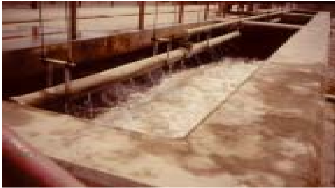
Mezclador hidráulico
