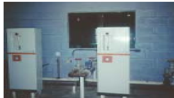
Cloradores de solución al vacío
