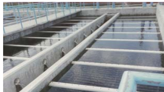
Decantador laminar de placas paralelas
